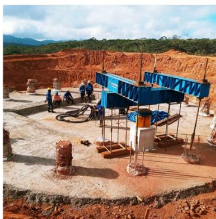
12 ensaios de prova de carga estática (PCE) em obra de aerogeradores. Urandi - Bahia.
